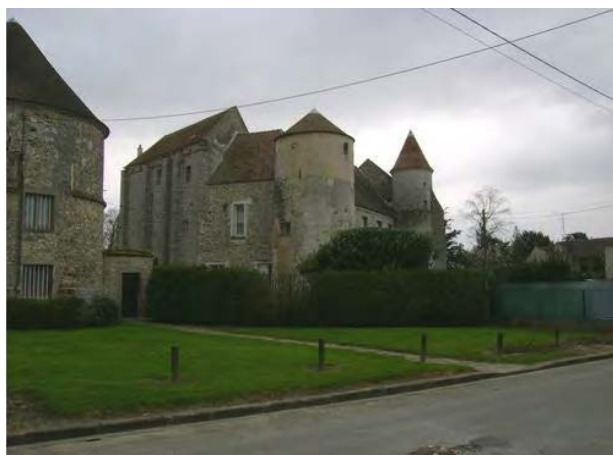
Ferme fortifiée de Pouilly le Fort
