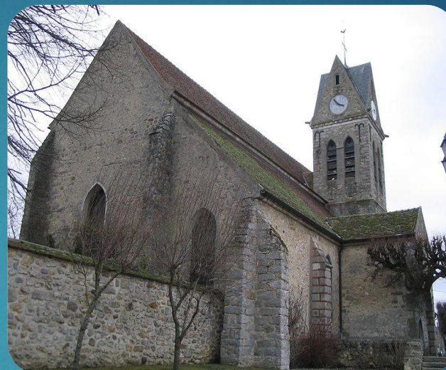
Réfection de la toiture de l'église
